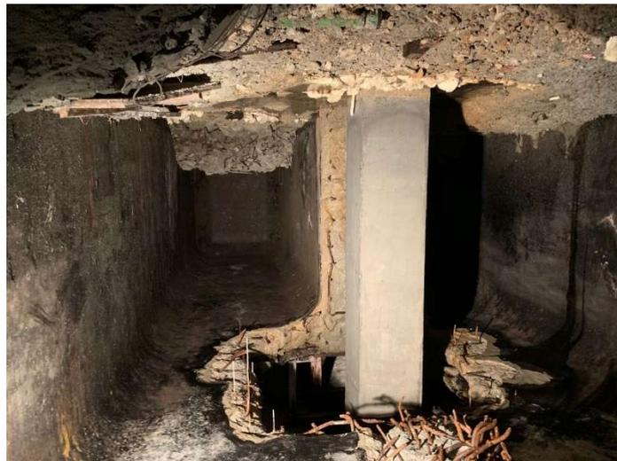
Un des piliers en béton qui ont été construits à travers les caves pour sécuriser le sol de fondation.
