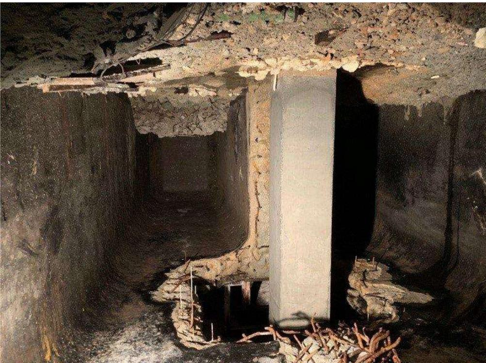
Einer der Betonpfeiler, welche zur Sicherung des Baugrundes durch die Keller hindurch erstellt wurden.
